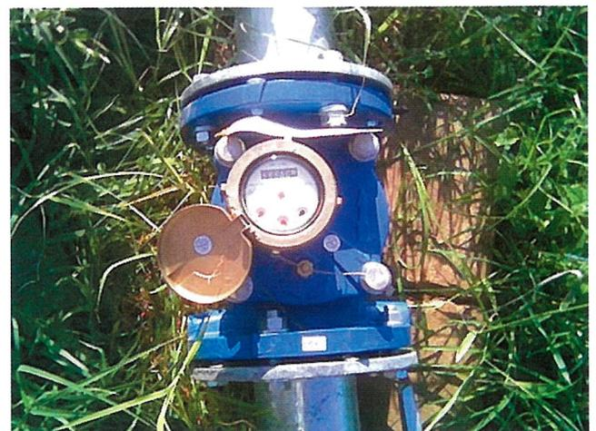
Foto 4 "Contaltri utilizzato su irrigazione per aspersione"
